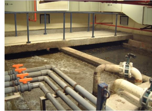
Tòa nhà VCB, Hanoi
